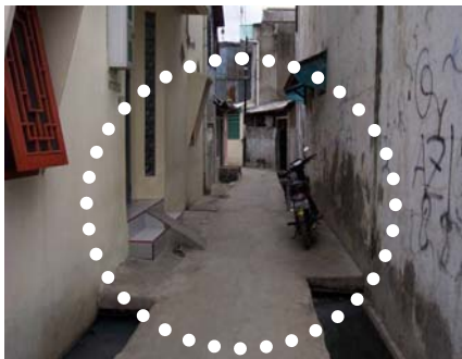
Pic. 9. Saluran drainase ditutup untuk parkir kendaraan dan perluasan sisi rumah
